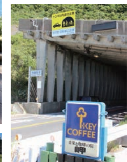
富津市側から見た入口 安房郡鋸南町側から、トンネルを抜けたらすぐ左側に現れる看板
