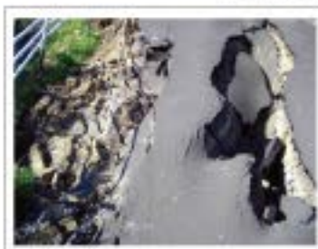
印西市山田付近
